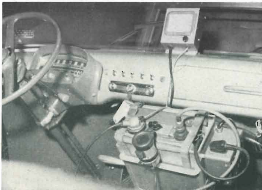
Fig. 3 - L'apparecchio Teleport della TELEFUNKEN installato sull'autoambulanza: è visibile l'altoparlante-amplificatore è il tampono di alimentazione (lato destro).
